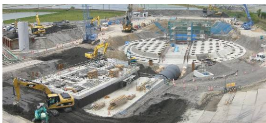
写真-5 場内施工状況
