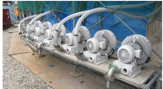
写真-1 シースクーリング実施状況
