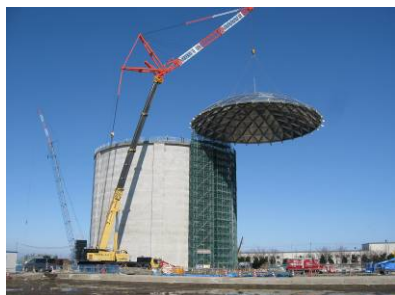
写真-3 アルミドーム架設状況
