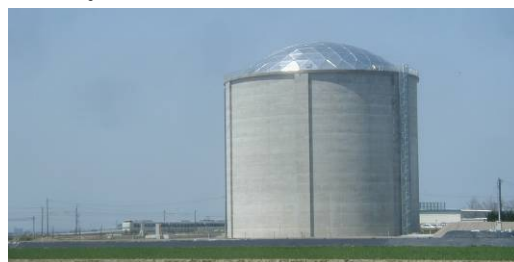
写真-6 完成写真
