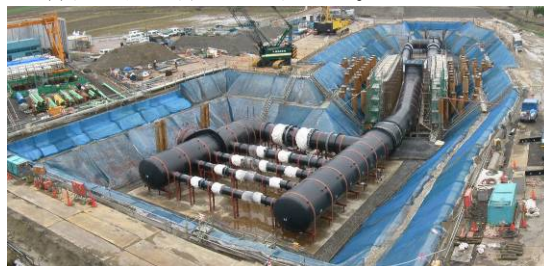
写真-4 管体工施工状況
